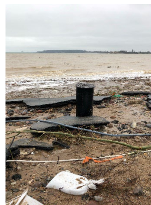
Figur 5 - Vej skyllet væk rundt om dæksel
