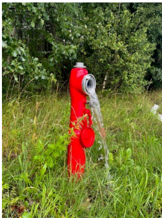
Figur 2 - Vi skyller ledningsnettet
