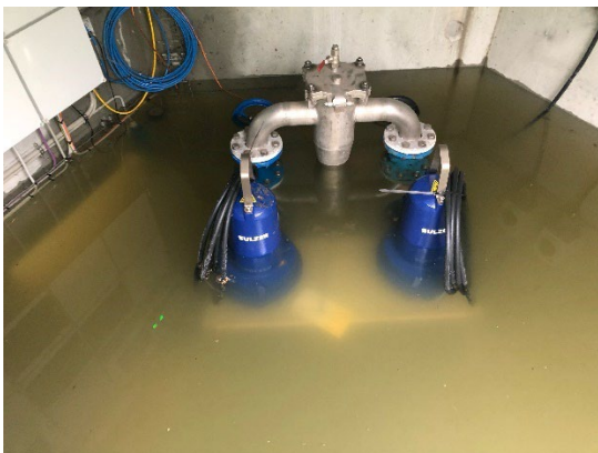
Figur 4 - Druknedede pumper
